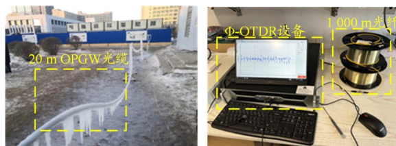
(a) 光缆架设现场图 (b) \Phi -OTDR设备现场图
