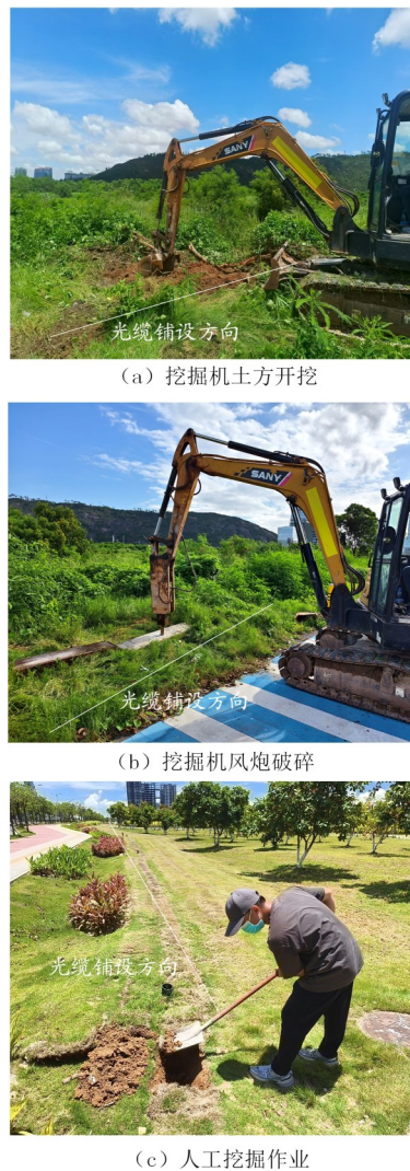
图4 3类典型施工场景
